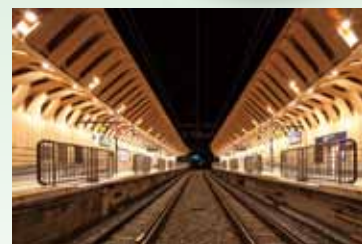
東急池上線 戸越銀座駅 (多摩産材を使用した駅舎)
